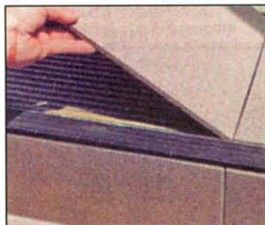
Плитку кладут так, чтобы её край совместился заподлицо с верхней кромкой профиля.
