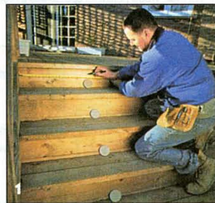
Размечают положение светильников на подступёнках. Так как специальные светильники отличаются повышенной прочностью, их можно ставить практически везде.
