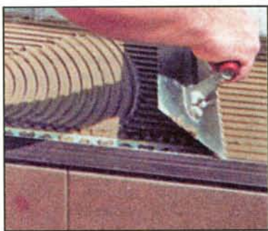
Дополнительный профиль, укладываемый на слой клея. Крепёжная полка профиля полностью укрывается клеем.
