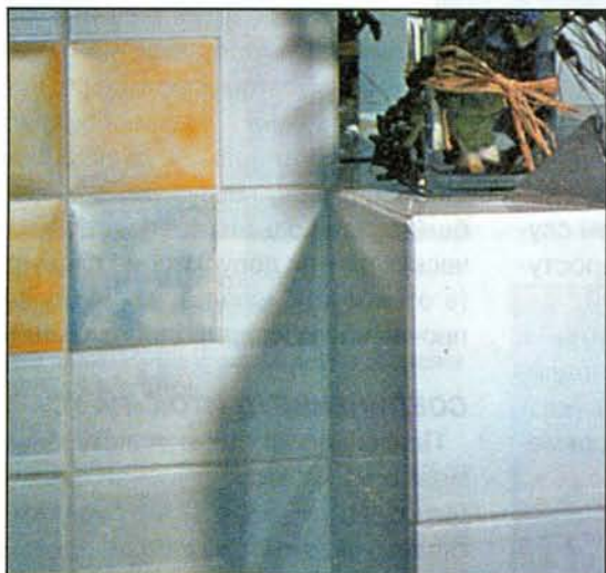
Пример соединения «на ус» вертикальной и горизонтальной плиток. Шов между плитками приходится строго на ребро выступа.
